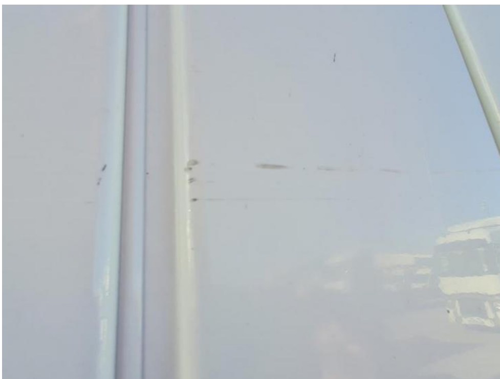
Fot. 30. ściana boczna L
